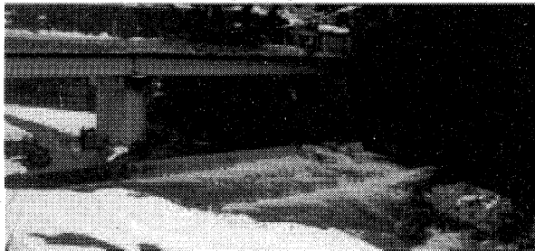
図10 八十島用水頭首工
