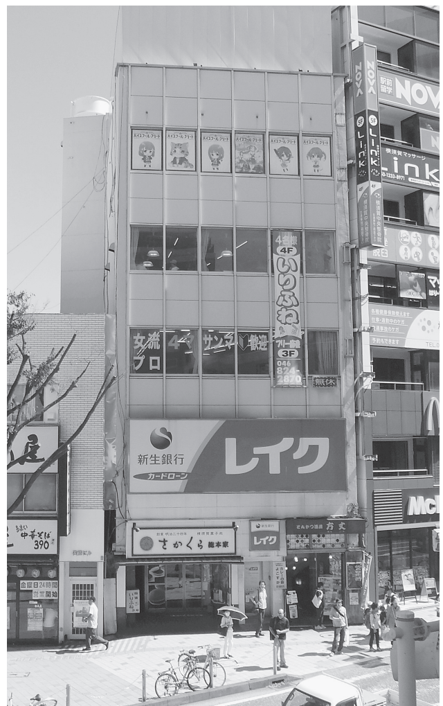
図1 坂倉ビル (2018年1月撮影)
