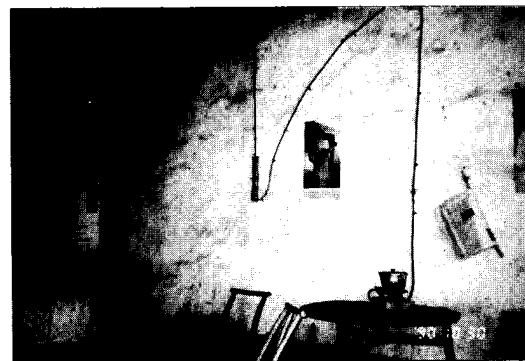
図-6 頼さん宅の台所の片隅。メタンガス発生装置から引いてきた管が壁を這い、先端のコンロに鍋がかけてある。
